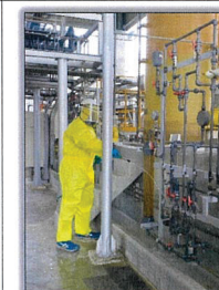
PO รายงานทำความสะอาดพื้นที่ ล้างรางระบายสารเคมี และเปิด Valve Drain ลง Neutralize Pit แล้ว
